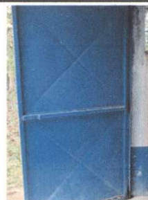
Mantenimiento a estructura (lijado, cambio de tubo , cepillado, sujeciones, aplicación de pintura) ✓
