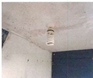
Instalación de unidades luz (incluye interruptor, ducto y cable eléctrico)
