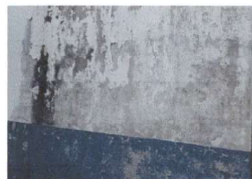
Pintura en muros exteriores e interiores ✓
