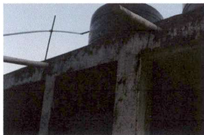
Sustitución de depósito de agua 1000 lt
