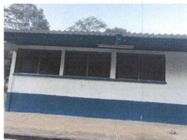
Sustitución de lámina, por lámina troquelada aluzinc calibre 26 ✓
