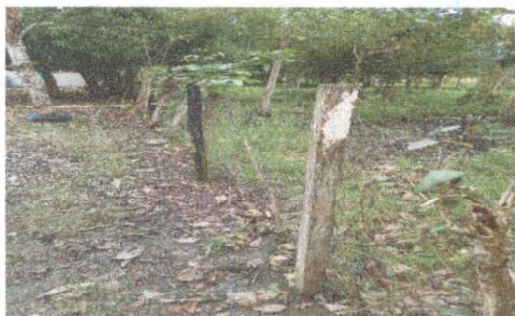
Repación de cerco de alambre de pua
