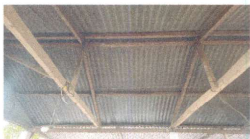
Repación de cableado electrico
