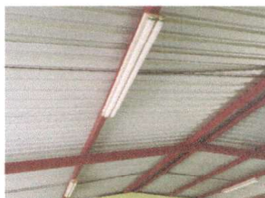
Sustitución de lamparas por focos ahorradores
