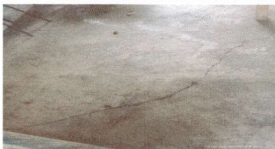
Reparación de torta de concreto
