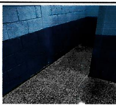
Foto 4: Sustitución de piso de granito
