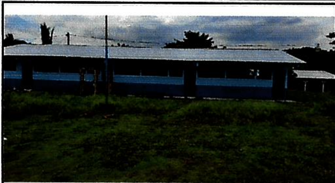
Foto1: Sustitución de lámina, por lámina troquelada calibre 26 de 20 pies, Sustitución de lámina, por lámina troquelada calibre 26 de 17 pies
