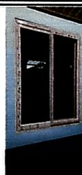
Foto 2: Sustitución de ventanas de madera por PVC mas vidrio (1.17 X 1.63)
