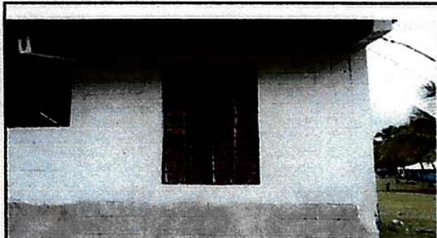
Sustitución de ventanas de madera por PVC mas vidrio (1.17 X 1.63)
