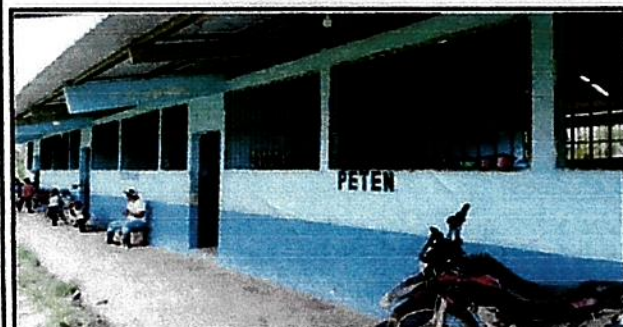
pintura en muros
