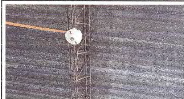
Foto 10: 17.5 SUSTITUCIÓN DE PLAFONERAS
