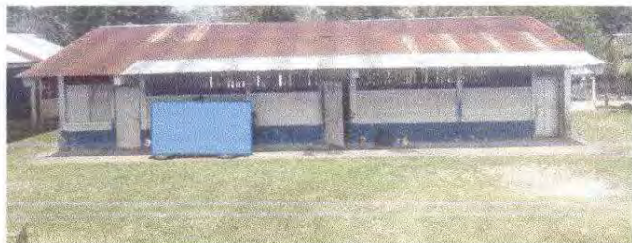
Foto 1: 1.1 SUSTITUCIÓN DE LAMINA, POR LAMINA TROQUELADA ALUZINC CALIBRE 26
