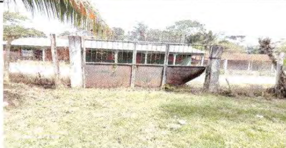
Foto 8: 12.1 MANTENIMIENTO A PORTONES DE METAL
