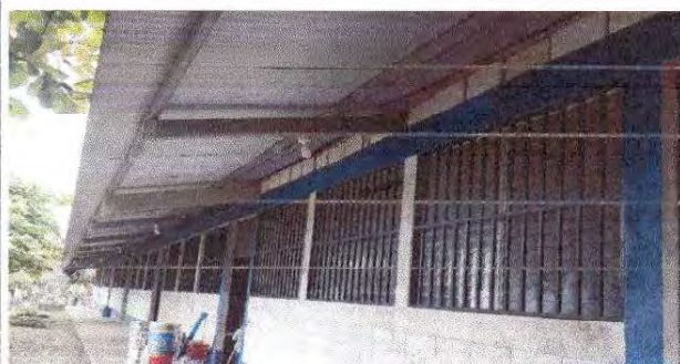
Foto 4: 5.7 MANTENIMIENTO A BALCONES DE METAL
