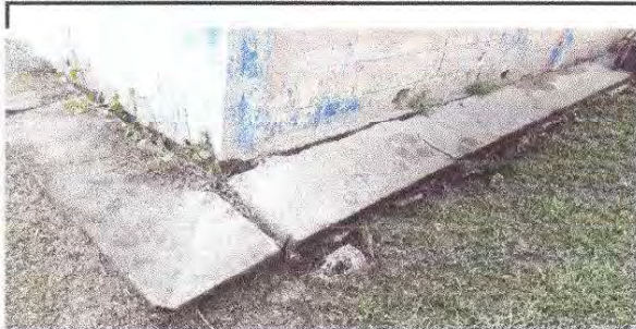
Foto 7: 8.2 REPARACIÓN DE BANQUETAS DE CONCRETOS
