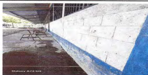
Foto 6: 9.1 PINTURA EN MUROS EXTERIORES E INTERIORES
