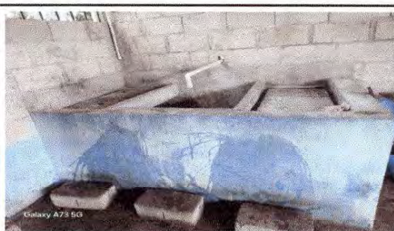
Foto 10: 18.4 REPARACIÓN DE CISTERNA DE CONCRETO
