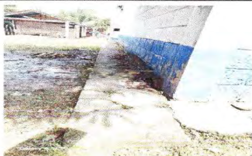
Foto 5: 8.2 REPARACIÓN DE BANQUETAS DE CONCRETO
