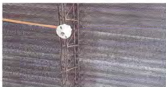
Foto 9: 17.3 SUSTITUCIÓN DE LAMPARAS TIPO LED
