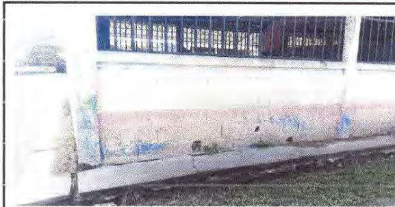
Foto 8: 9.1 PINTURA EN MUROS EXTERIORES E INTERIORES
