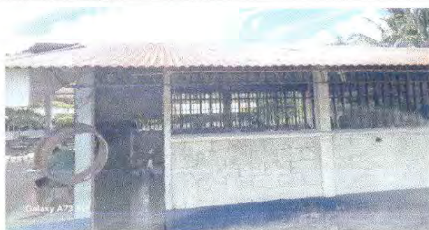
Foto1: 1.1 SUSTITUCIÓN DE LAMINA POR LAMINA TROQUELADA ALUZINC CALIBR 26
