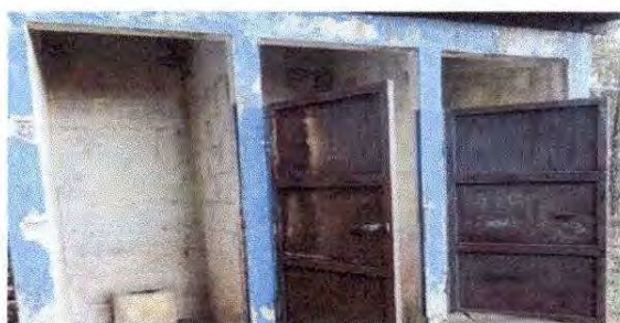
Foto 11: 19.4 FABRICACIÓN E INSTALACIÓN DE PUERTAS DE METAL EN BAÑOS
