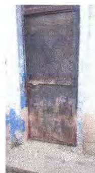
Foto 4: 4.3 SUSTITUCIÓN DE PUERTAS
