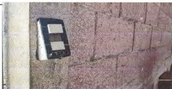
Foto 11: 17.7 SUSTITUCIÓN INTERRUPTORES DOBLES
