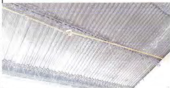
Foto 13: 17.11 REPARACIÓN DE CABLEADO ELECTRICO
