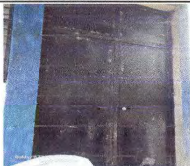
Foto 3: 4.1 MANTENIMIENTO A ESTRUCTURA (LIJADO, CEPILLADO, APLICACIÓN DE PINTURA)
