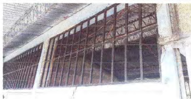
Foto 6: 5.7 MANTENIMIENTO A BALCONES DE METAL
