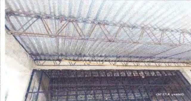
Foto2: 2.3 SUSTITUCIÓN DE ESTRUCTURA DE SOPORTE METAL POR METAL, COSTANERA 2'X3' CALIBRE 16+ INSTALACIÓN
