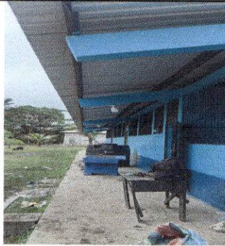
Foto7: Reparación de sistema eléctrico
