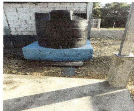
Foto 10: Sustitución de depósito de agua 1700 lt
