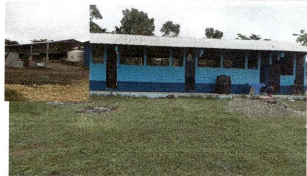
Foto 4: Pintura en muros exteriores e interiores
