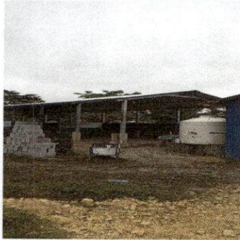
Foto1: Sustitución de lámina, por lamina troquelada aluzinc calibre 26
