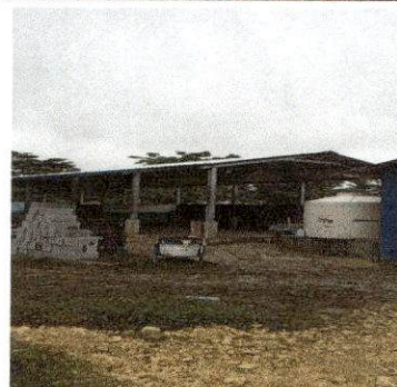
Foto 2: Sustitucion de estructura de soporte de madera, por metal
