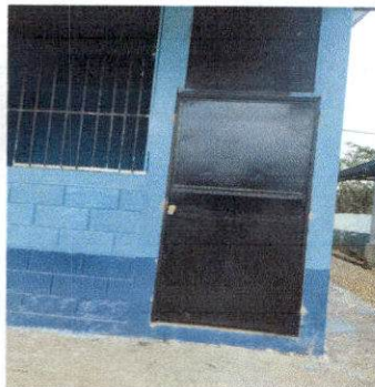
Foto 3: Sustitución de puertas
