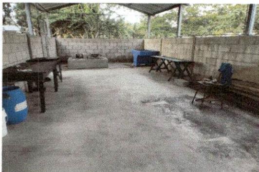
Foto 5: Reparación de piso de torta de concreto
