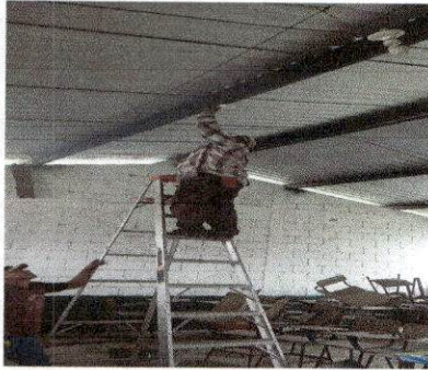
Foto7: Reparación de sistema eléctrico
