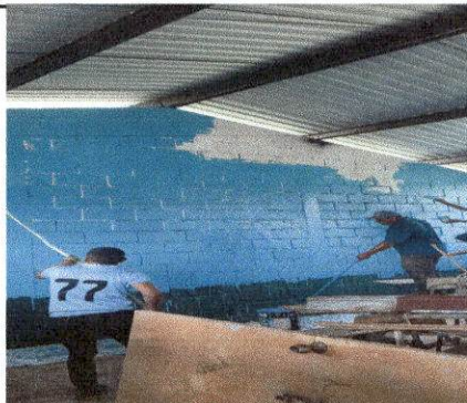
Foto 4: Pintura en muros exteriores e interiores
