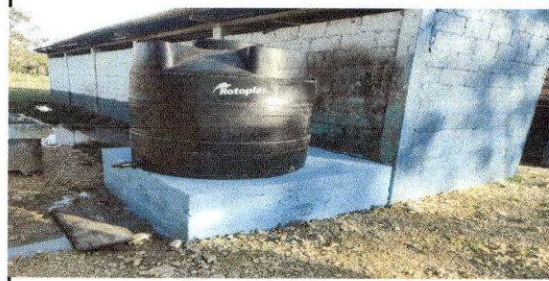
Foto8: Canales y Bajadas de agua pluvial
