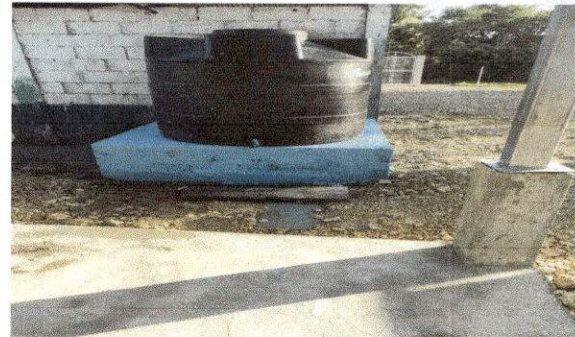
Foto 10: Sustitución de depósito de agua 1700 lt
