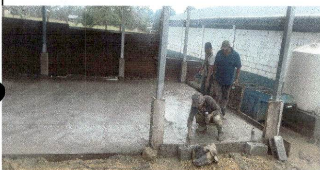
Foto 5: Reparación de piso de torta de concreto
