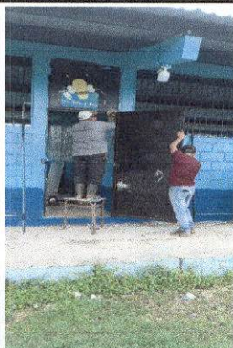
Foto 3: Sustitución de puertas
