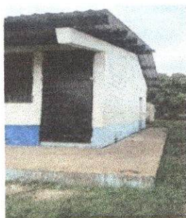
Foto 3: Sustitución de puertas
