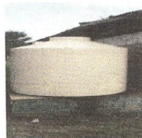
Foto 10: Sustitución de depósito de agua 1700 lt
