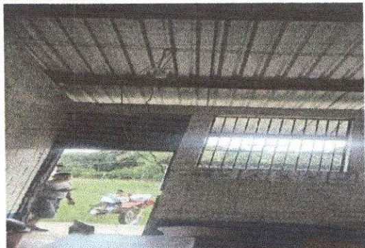
Foto7: Reparación de sistema eléctrico
