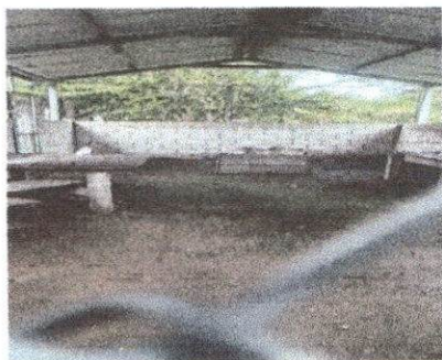
Foto 5: Reparación de piso de torta de concreto
