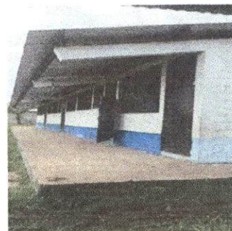
Foto 4: Pintura en muros exteriores e interiores
