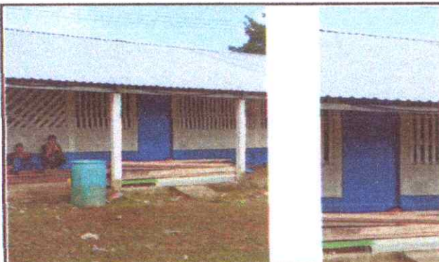
Foto 5: Sustitución de puerta
