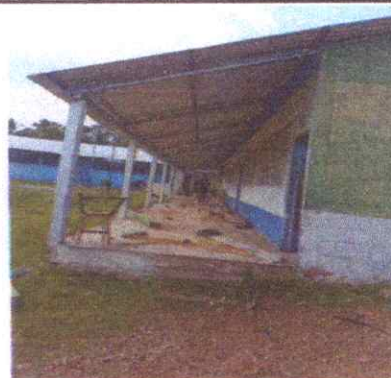
Foto 4: Sustitución de lámina, por lámina troquelada aluzinc calibre 26, Sustitución de estructura de soporte de madera, por metal
