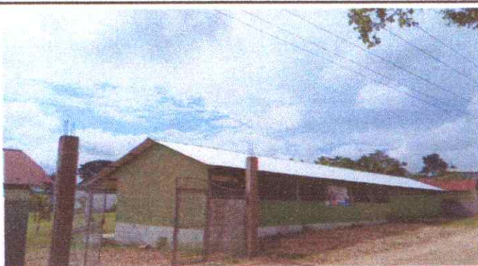
Foto 3: Sustitución de lámina, por lámina troquelada aluzinc calibre 26, Sustitución de estructura de soporte de madera, por metal
