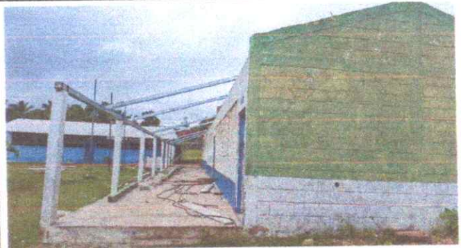
Foto 4: Sustitución de lámina, por lámina troquelada aluzinc calibre 26, Sustitución de estructura de soporte de madera, por metal
