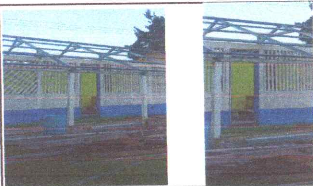
Foto 5: Sustitución de puerta
