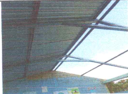
Foto 2: Sustitución de lámina, por lámina troquelada aluzinc calibre 26, Sustitución de estructura de soporte de madera, por metal
