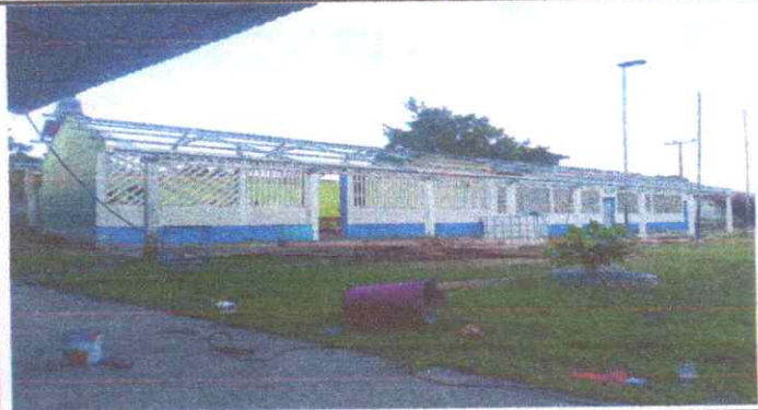
Foto 1: Sustitución de lámina, por lámina troquelada aluzinc calibre 26, Sustitución de estructura de soporte de madera, por metal
