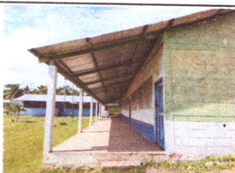
Foto 4: Sustitución de lámina, por lámina troquelada aluzinc calibre 26, Sustitución de estructura de soporte de madera, por metal
