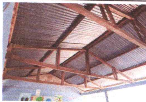
Foto 2: Sustitución de lámina, por lámina troquelada aluzinc calibre 26, Sustitución de estructura de soporte de madera, por metal
