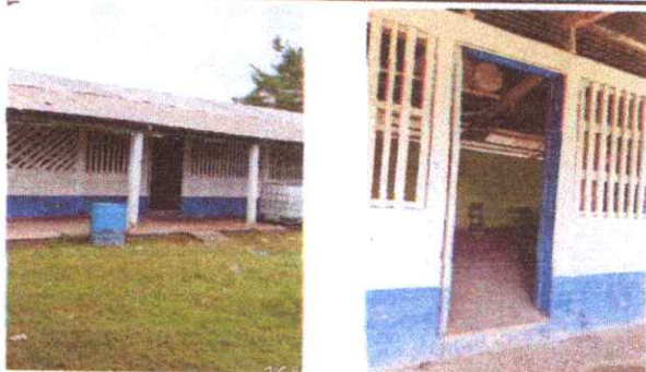
Foto 5: Sustitución de puerta
