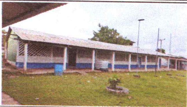
Foto 1: Sustitución de lámina, por lámina troquelada aluzinc calibre 26, Sustitución de estructura de soporte de madera, por metal
