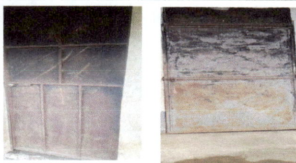
Foto 4 Sustitución de puerta
