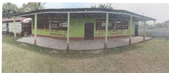
Foto 3: Sustitución de piso de torta de concreto
