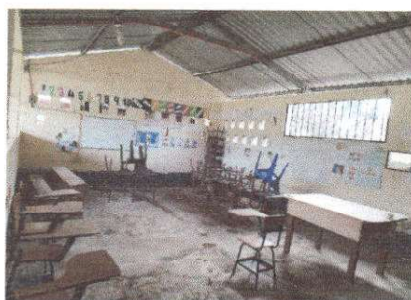
Foto 5: sustitucion de piso de cemento liquido
