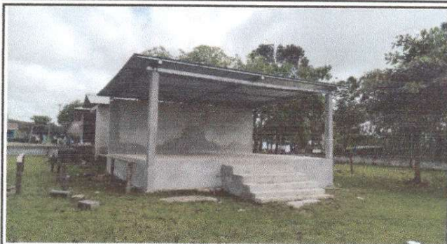
Foto 1: Pintura en muros exteriores e interiores.
