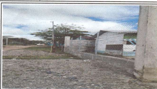
Foto 2: Pintura en muros exteriores e interiores.
