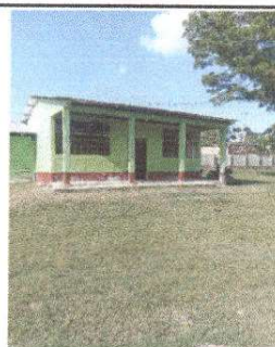
Foto 6: sustitucion de lamina troquelada aluzinc calibre 26
