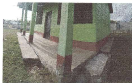
Foto 4: Sustitución de piso de torta de concreto.
