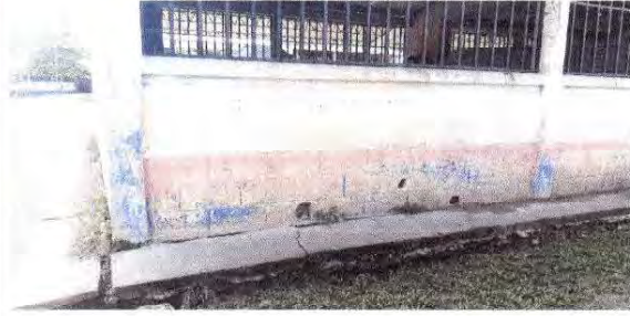
Foto 8: 9.1 PINTURA EN MUROS EXTERIORES E INTERIORES
