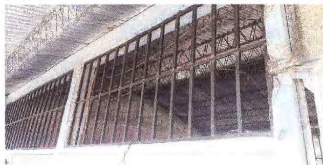
Foto 6: 5.7 MANTENIMIENTO A BALCONES DE METAL
