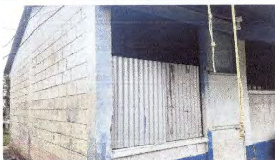
Foto 5: 5.2 SUSTITUCIÓN DE ESTRUCTURA DE METAL DE VENTANA
