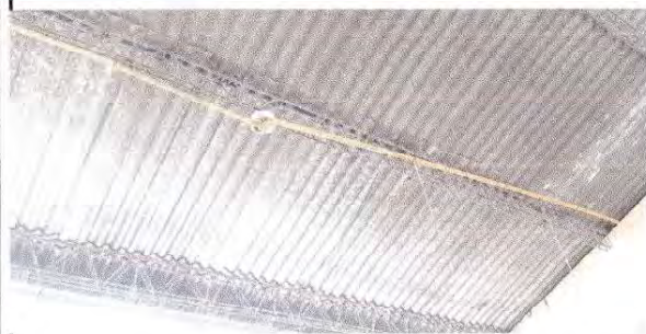
Foto 13: 17.11 REPARACIÓN DE CABLEADO ELECTRICO
