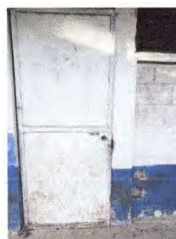
Foto 4: 4.3 SUSTITUCIÓN DE PUERTAS
