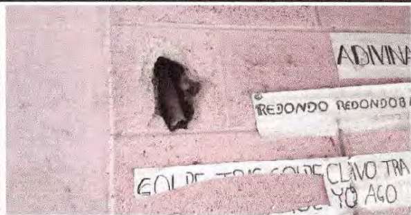
Foto 12: 17.8 SUSTITUCIÓN DE TOMACORRIENTES DOBLES
