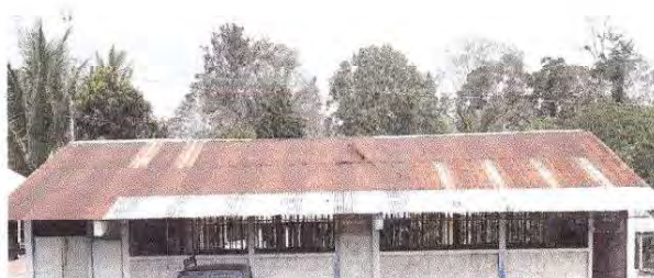
Foto 2: 1.2 SUSTITUCIÓN DE CAPOTE DE LAMINA PARA LAMINA TROQUELADA
