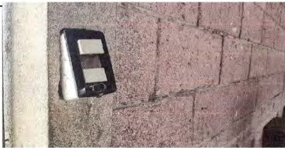
Foto 11: 17.7 SUSTITUCIÓN INTERRUPTORES DOBLES
