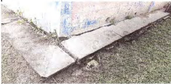
Foto 7: 8.2 REPARACIÓN DE BANQUETAS DE CONCRETOS
