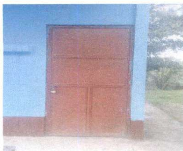
Foto 3: sustitucion de puerta de metal
