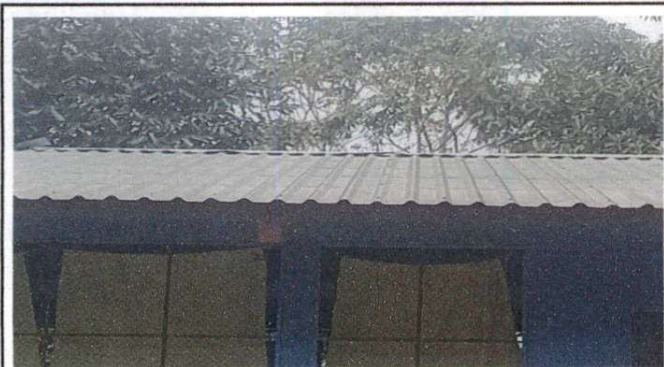
Foto1: SUTITUCION DE LAMINA , POR LAMINA TROQUELADA ALUZINC CALIBRE 26
