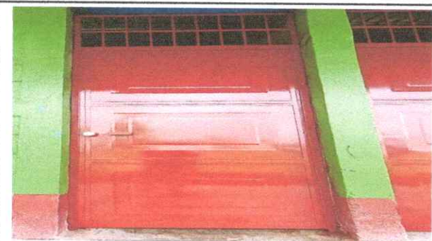
Foto 5: SUSTITUCION DE PUERTAS DE METAL
