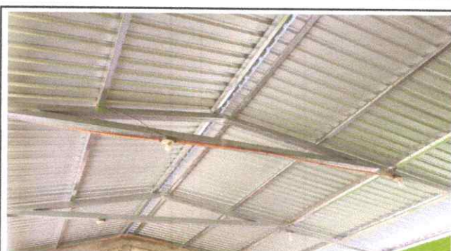
Foto 4: SUSTITUCION DE ESTRUCTURA DE SOPORTE
