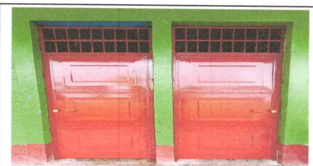
Foto 6 SUSTITUCION DE PUERTA DE METAL
