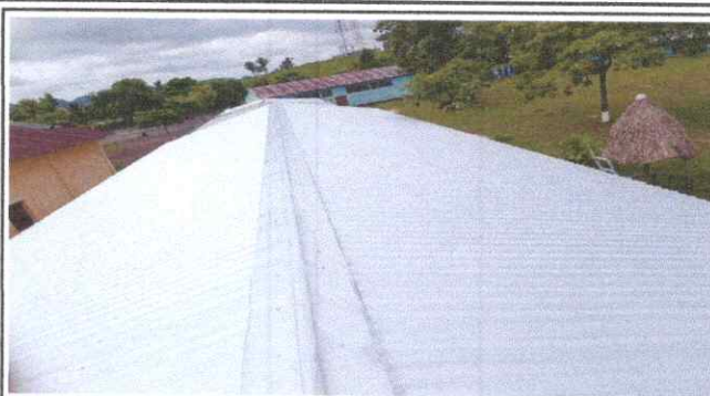
Foto 2: SUSTITUCION DE TECHO
