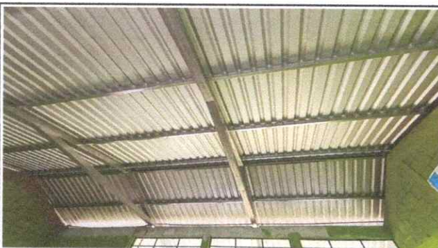
Foto 3: SUSTITUCION DE ESTRUCTURA DE SOPORTE
