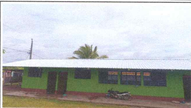
Foto 1: SUSTITUCION DE TECHO
