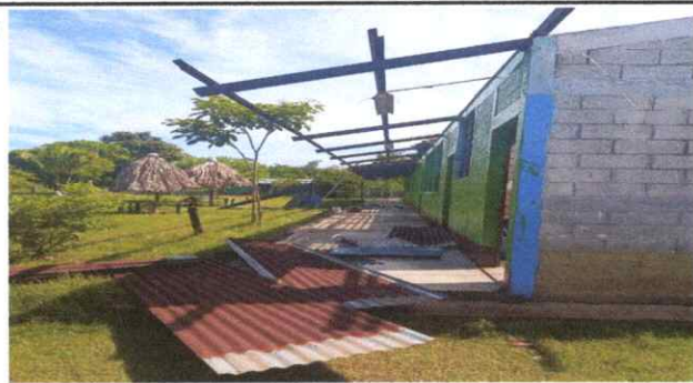
Foto 3: SDESINSTALACION DE ESTRUCTURA PORTANTE
