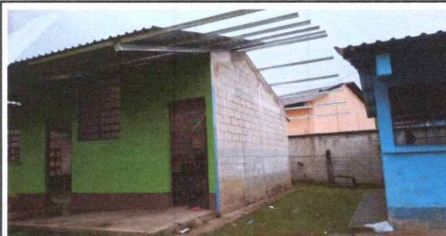
Foto 6 SUSTITUCION DE LAMINA
