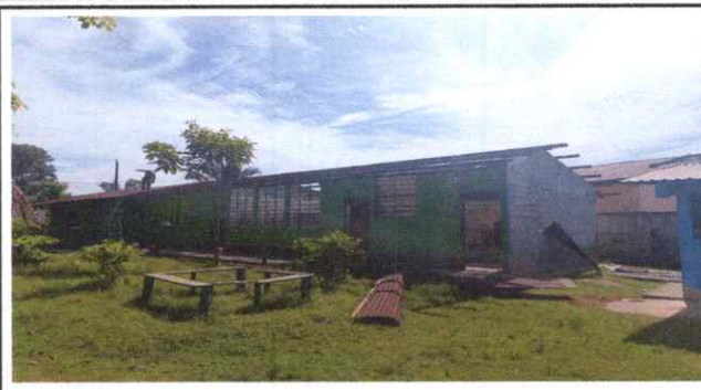
Foto 2: DESINSTALACIÓN DE LÁMINA
