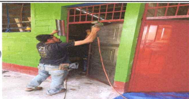
INSTALACION DE PUERTAS
