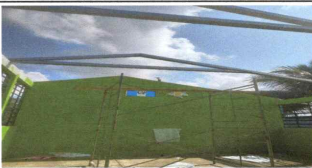
Foto 5: SUSTITUCION DE ESTRUCTURA DE SOPORTE
