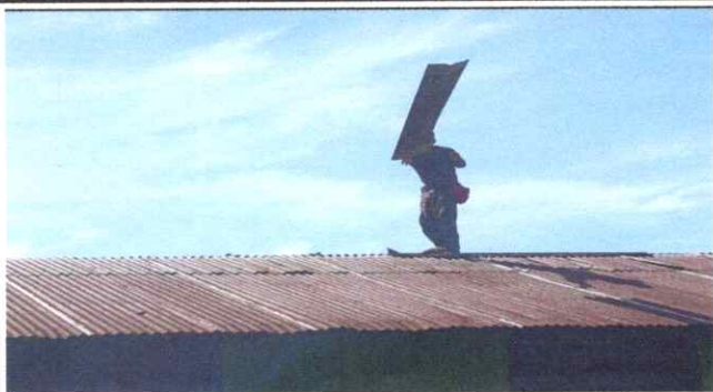
Foto 1: DESINSTALACIÓN DE LAMINA
