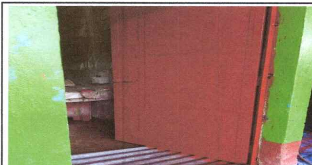
INSTALACIÓN DE PUERTA
