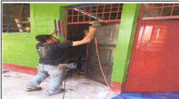
INSTALACIÓN DE PUERTA
