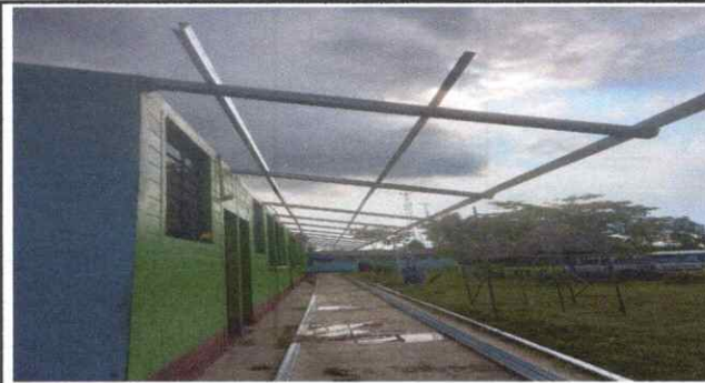
Foto 4: SUSTITUCION DE ESTRUCTURA DE SOPORTE
