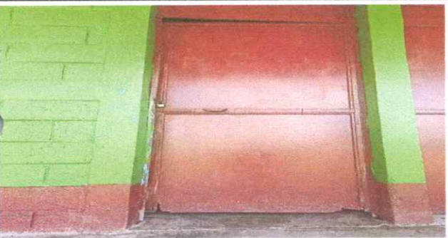
Foto 5: SUSTITUCION DE PUERTAS DE METAL
