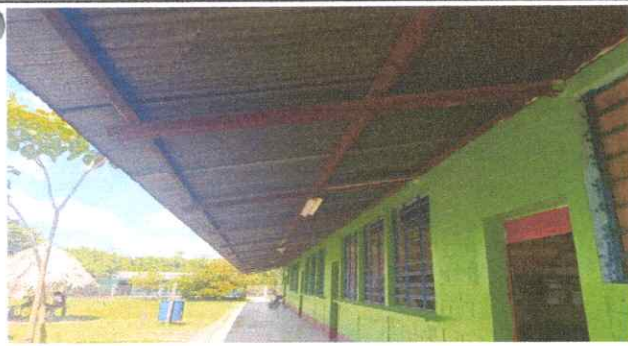
Foto 3: SUSTITUCION DE ESTRUCTURA DE SOPORTE
