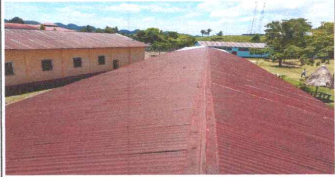
Foto 2: SUSTITUCION DE TECHO
