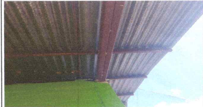
Foto 4: SUSTITUCION DE ESTRUCTURA DE SOPORTE
