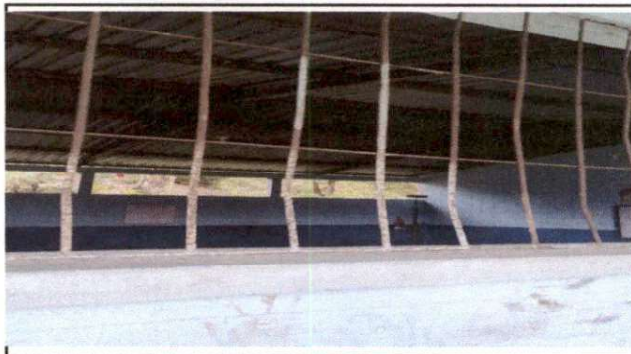
Foto 2: Sustrucción de balcones de metal.
