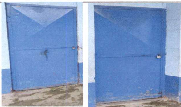
Foto 3: Sustrucción de puertas.
