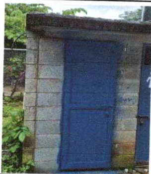
Foto 1: Sustrucción de puerta en servicios sanitarios
