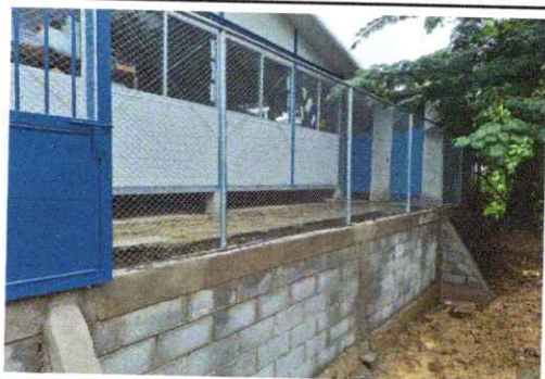
Foto 3: Reparación de muro de contención y tubo Hg y malla galvanizada.
