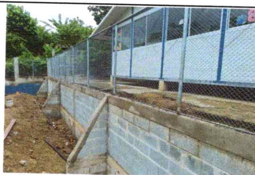
Foto 4: Reparación de muro de contención y tubo Hg y malla galvanizada.
