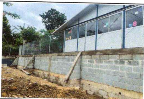
Foto 5: Reparación de muro de contención y tubo Hg y malla galvanizada.
