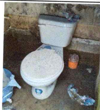
Foto 2: Sustrucción de de inodoros.
