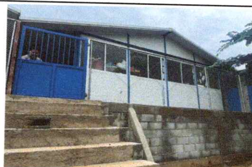
Foto 6: Reparación de muro de contención y tubo Hg y malla galvanizada.
