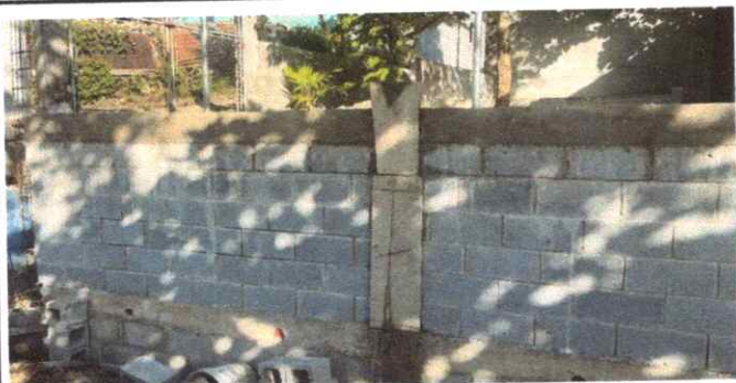
Foto 5: Reparación de muro de contención y tubo Hg y malla galvanizada.
