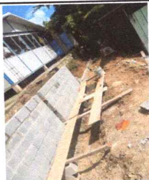
Foto 3: Reparación de muro de contención y tubo Hg y malla galvanizada.
