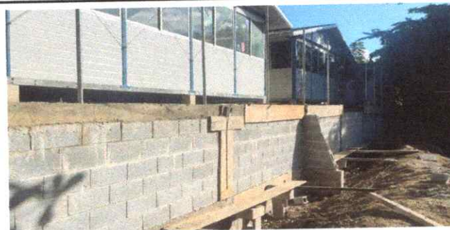
Foto 6: Reparación de muro de contención y tubo Hg y malla galvanizada.
