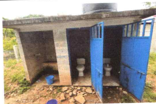
Foto 2: Sustitución de de inodoros.
