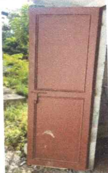
Foto 1: Sustitución de puerta en servicios sanitarios
