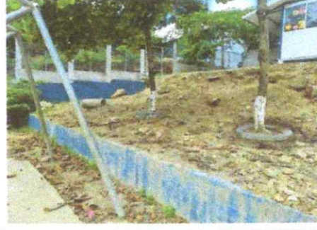
Foto 2: Reparación de muro de contención y tubo Hg y malla galvanizada.
