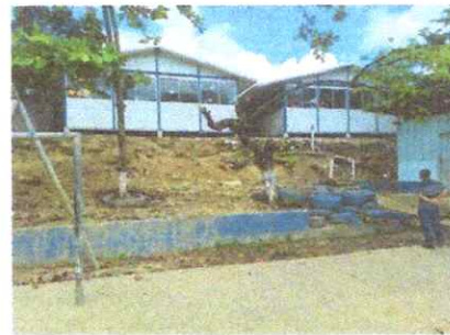
Foto 4: Reparación de muro de contención y tubo Hg y malla galvanizada.
