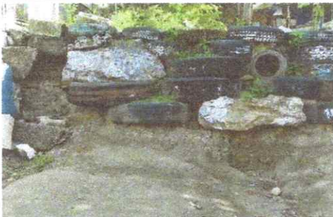
Foto 5: Reparación de muro de contención y tubo Hg y malla galvanizada.
