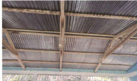
FOTO 2: SUSTITUCION DE ESTRUCTURA DE MADERA, POR METAL
