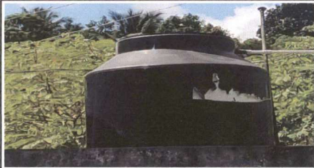
FOTO 4: SUSTITUCION DE DEPOSITO DE AGUA 1700 LT
