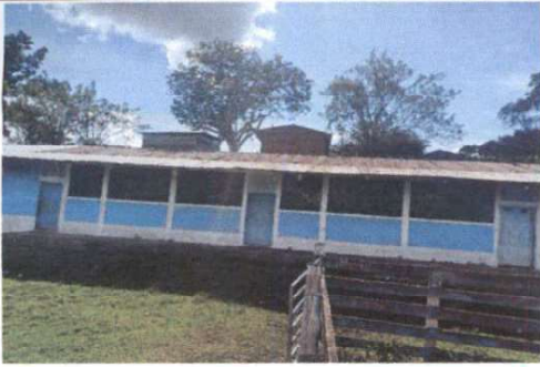
FOTO 1: SUSTITUCION DE LAMINA, POR LAMINA TROQUELADA ALUZINC CALIBRE 26
