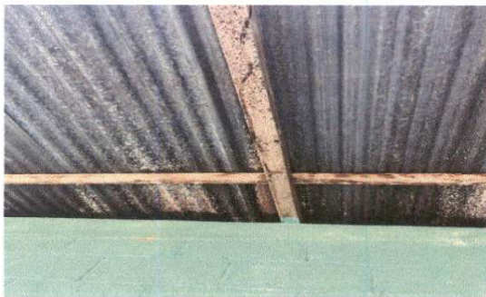
Foto 5: Sustitucion de elementos de fijación ✓
