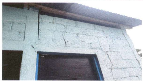
Foto 6: Sellado de grietas de fisuras en muro. ✓
