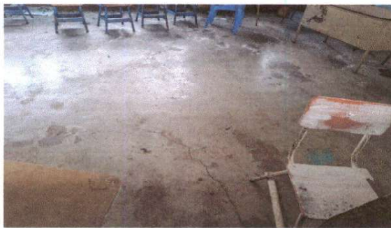
Foto 3: Sustitución de piso de cemento líquido. ✓
