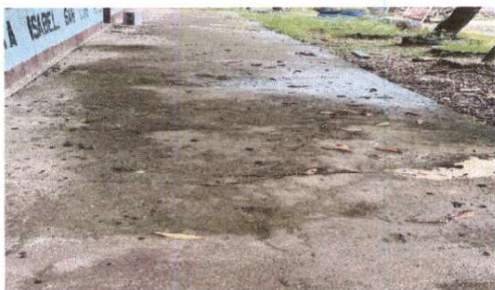
Foto1: Reparación de plancha de cemento de patio.
