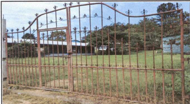
Foto 9: Mantenimientos a portones de metal ✓
