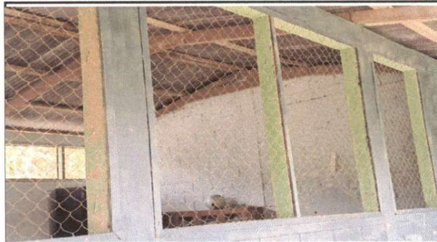
Foto 8: Sustrucción de balcones de metal ✓
