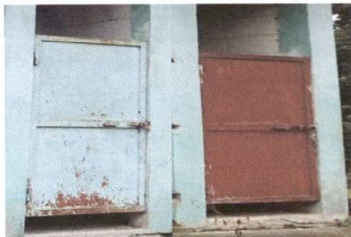
Foto 7: Sustrucción de puertas en servicios sanitarios ✓
