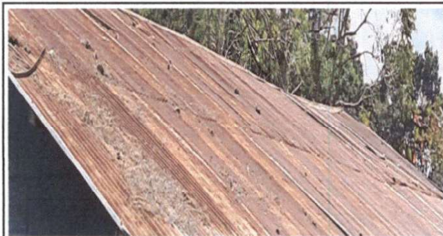
Foto 3: Sustitución de elementos de fijación
