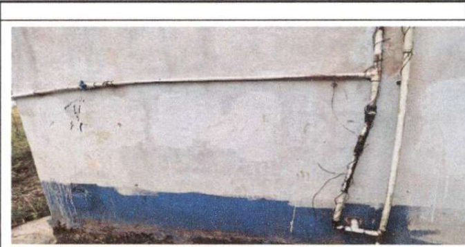
Foto 4: Sustitución de tubería línea principal
