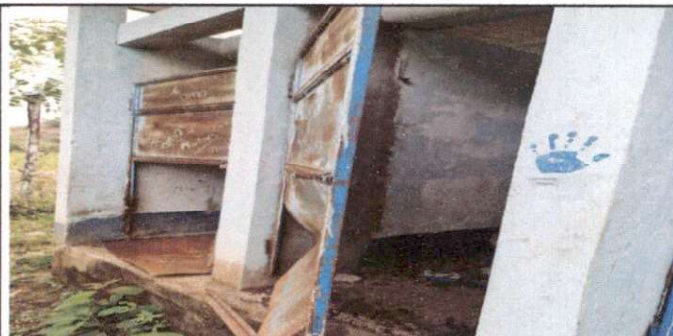
Foto 6: Sustitución de puertas en servicios sanitarios.
