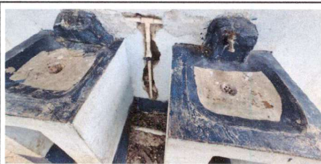
Foto 5: Sustitución de llave de chorro.
