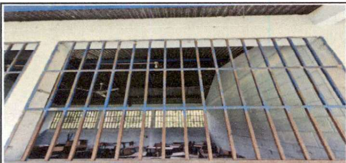
Foto 1: Mantenimiento a balcones de metal.
