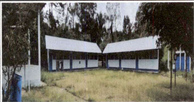
Foto 1: Pintura en muros exterior e interior.
