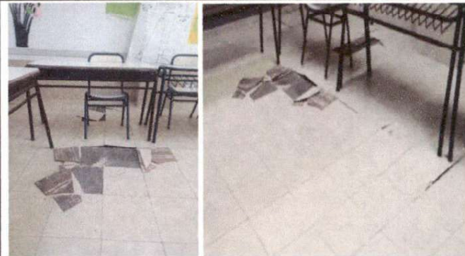
Foto 2: Sustitución de piso cerámico.
