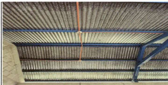
Foto 4: Sustitución de ducto eléctrico + accesorio.
