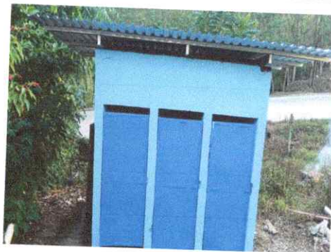
FOTO 4: SUSTITUCION DE PUERTAS DE BAÑOS
