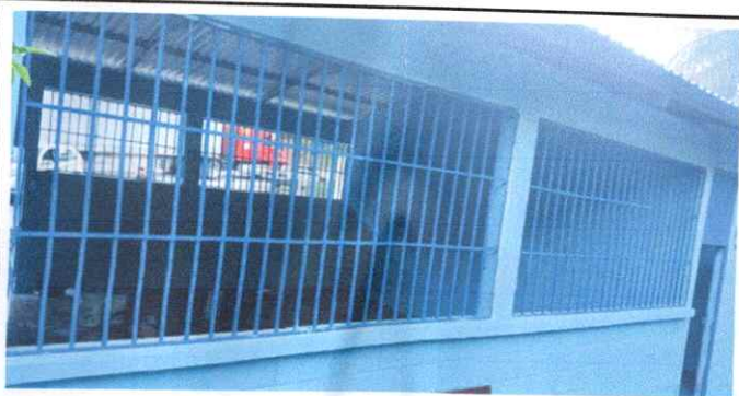
FOTO 5: SUSTITUCION DE VENTANAS POR BALCONES
