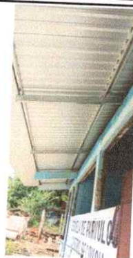
FOTO 2: SUSTITUCION DE ESTRUCTURA DE MADERA, POR METAL
