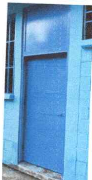
FOTO 3: SUSTITUCION DE PUERTA
