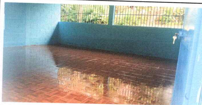
FOTO 6: SUSTITUCION DE PISO LISO POR PISO CERAMICO
