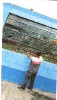
FOTO 5: SUSTITUCION DE VENTANAS POR BALCONES
