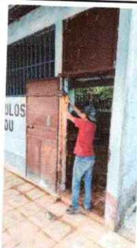
FOTO 3: SUSTITUCION DE PUERTA
