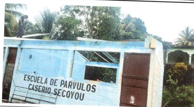
FOTO 2: SUSTITUCION DE ESTRUCTURA DE MADERA, POR METAL
