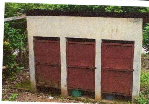
FOTO 4: SUSTITUCION DE PUERTAS PARA BAÑOS
