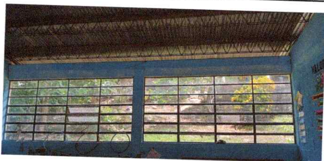
FOTO 5: SUSTITUCION DE VENTANAS POR BALCONES
