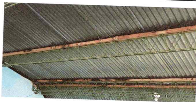
FOTO 2: SUSTITUCION DE ESTRUCTURA DE MADERA, POR METAL
