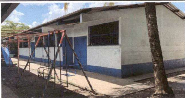
Foto 7. Pintura en muro exteriores e interiores.
