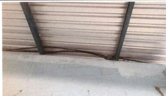
Foto 8. Sustitución de ducto eléctrico + accesorios.
