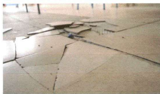
Foto 6. Sustrucción de piso cerámico.
