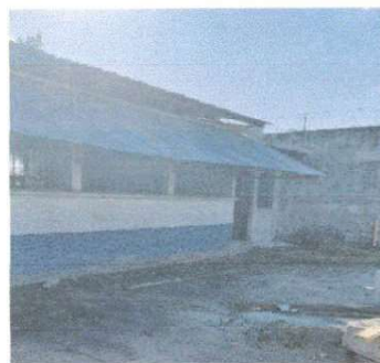
Foto 2. Sustrucción de estructura de soporte de madera, por metal.
