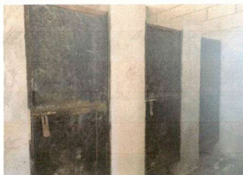
Foto 4. Sustrucción de puertas en servicios sanitarios
