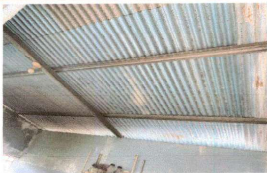
Foto 1. Sustrucción de lámina, por lámina troquelada aluzinc calibre 26.
