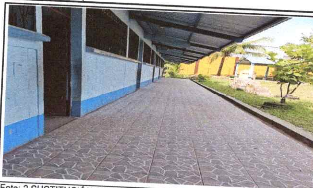
Foto 2: SUSTITUCIÓN DE LIQUIDO A CERÁMICA ANTIDESLIZANTE CORREDOR
