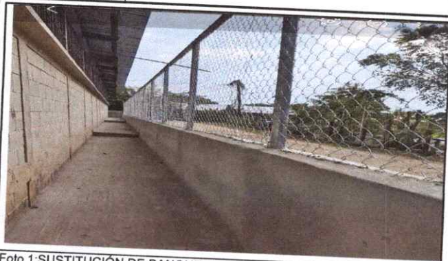
Foto 1: SUSTITUCIÓN DE BANQUETA
