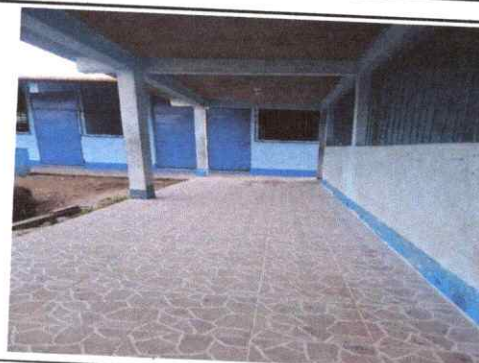
Foto 4: SUSTITUCIÓN DE PISO LÍQUIDO A CERÁMICA ANTIDESLIZANTE EN BAÑOS, DENTRO Y FUERA
