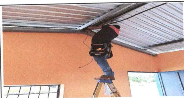
Foto: 5 DUCTO ELECTRICO MAS ACCESORIOS EN LA DIRECCIÓN Y LOS BAÑOS
