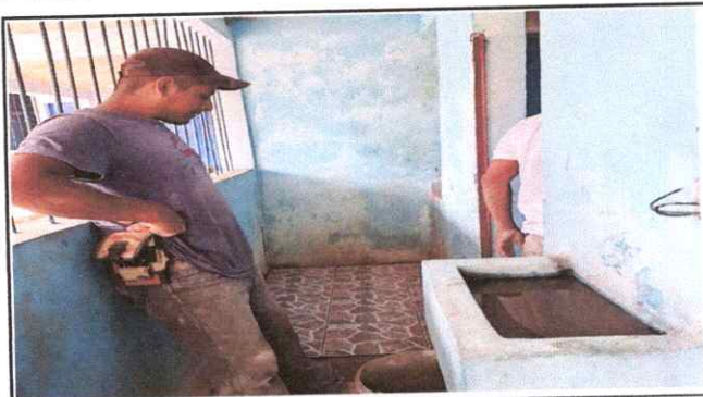
Foto: 4 SUSTITUCION DE PISO LÍQUIDO A CERAMICA ANTIDESLIZANTE EN BAÑOS, DENTRO Y FUERA
