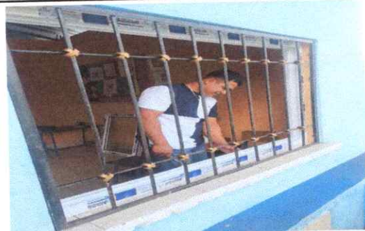
Foto: 6 FABRICACIÓN E INSTALACION DE VENTANAS
