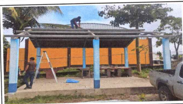
Foto: 3 SUSTITUCIÓN DE LAMINA DE LA GALERA
