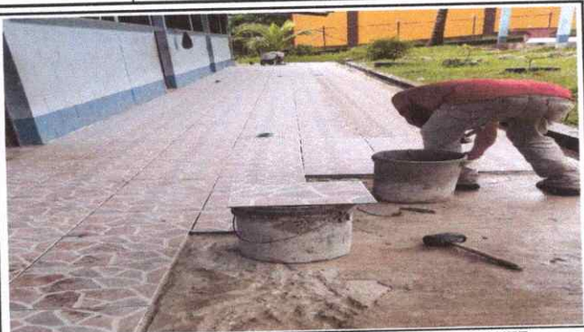
Foto 2 SUSTITUCIÓN DE LIQUIDO A CERÁMICA ANTIDESLIZANTE CORREDOR
