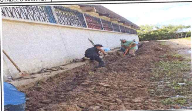
Foto 1: SUSTITUCIÓN DE BANQUETA
