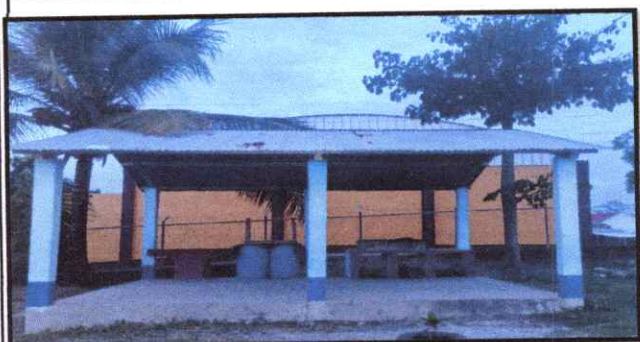
Foto 3: SUSTITUCIÓN DE LAMINA DE LA GALERA
