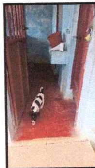
Foto 4: SUSTITUCIÓN DE PISO LIQUIDO A CERAMICA ANTIDESLIZANTE EN BAÑOS, DENTRO Y FUERA
