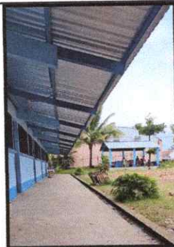
Foto 2: SUSTITUCIÓN DE LIQUIDO A CERAMICA ANTIDESLIZANTE CORREDOR
