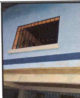
Foto 6: ACONDICIONAMIENTO DE COCINA
