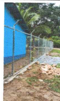
Foto 4: Trabajo finalizado de muro perimetral poste de tubo galvanizado y malla de 2 metros de alto.
