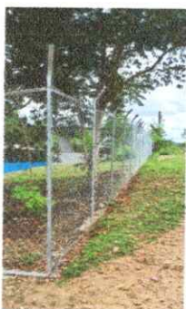
Foto 5: Muro perimetral finalizado con tubo galvanizado y malla
