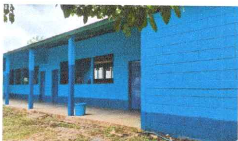
Foto 3: Finalización de pintura en muros exteriores e interiores
