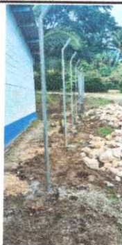
Foto: 3 fundición de los postes de tubo galvanizado
