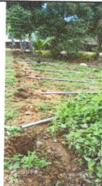
Foto: 2 Medición y ubicación de los postes de tubo galvanizado
