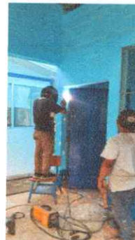
Foto: 6 Instalación de puertas nuevas de metal
