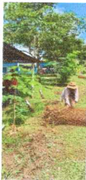
Foto 1: desinstalación de la malla en mal estado
