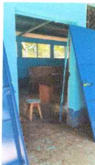
Foto: 5 Desinstalación de puertas en mal estado.
