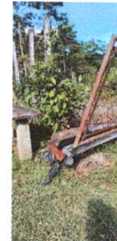
Foto 4: Desplome de poste de madera y malla
