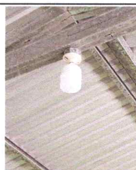
Foto 6: SUSTITUCION DE LAMPARAS TIPO LED
