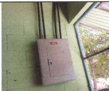
Foto 5: SUSTITUCION DE TABLEROS DE FLIPONES
