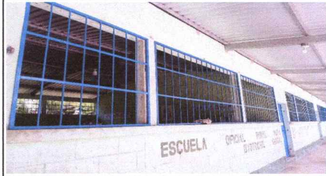
Foto 2: SUSTITUCION DE BALCONES DE METAL
