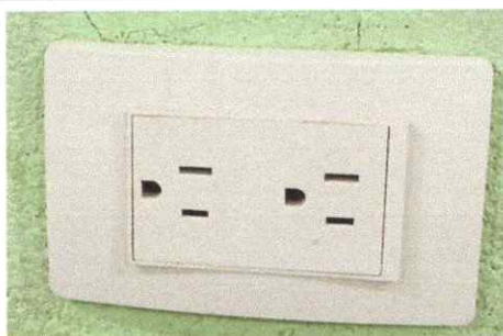
Foto 3: SUSTITUCION DE TOMACORRIENTES DOBLES
