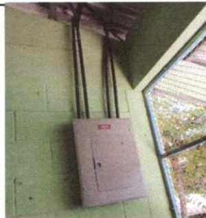
Foto 4: SUSTITUCION DE FLIPONES
