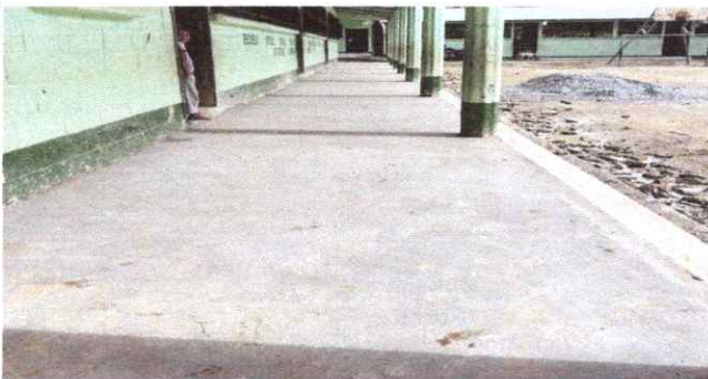
Foto 5: REPARACION DE PLANCHA DE CONCRETO DE PATIO
