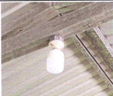
Foto 1: SUTITUCION DE PLAFONERAS.
