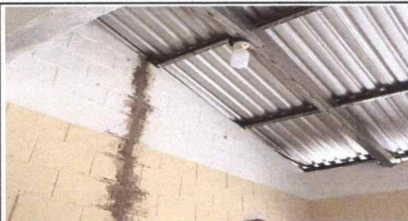
Foto 6: REPARACION DEL CABLEADO ELECTRICO
