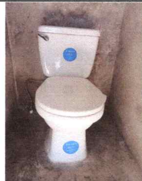
Foto 4: SUSTITUCION DE INHODOROS
