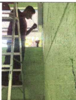
Foto: 4 SUSTITUCION DE FLIPONES
