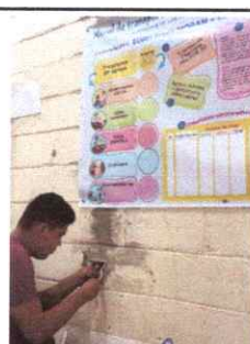
Foto: 6 REPARACION DEL CABLEADO ELECTRICO
