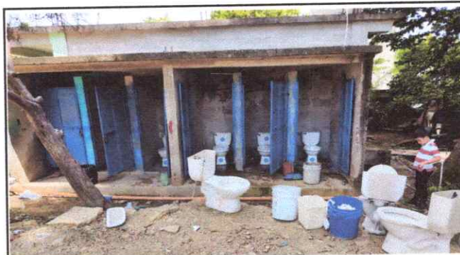
Foto: 4 SUSTITUCION DE INHODOROS
