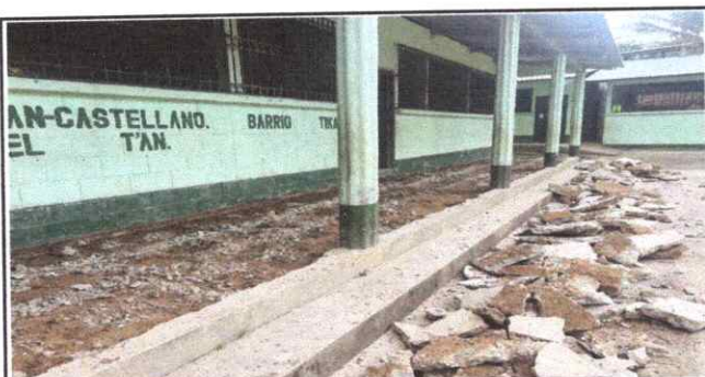
Foto 5: REPARACION DE PLANCHA DE CONCRETO DE PATIO
