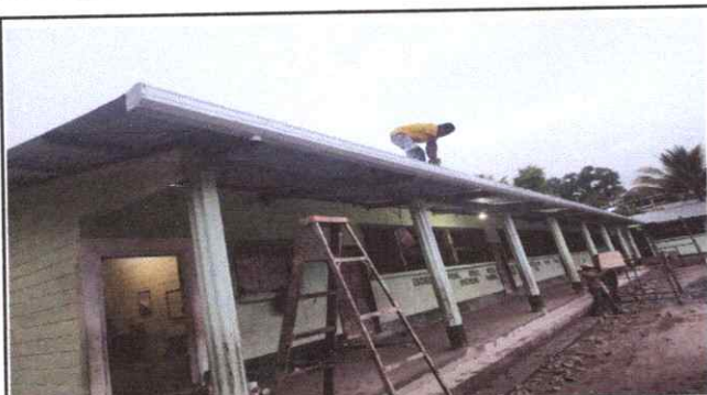
Foto: 3 SUSTITUCION DE CANAL DE METAL
