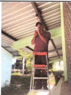
Foto 1. SUSTITUCION DE PLAFONERAS.
