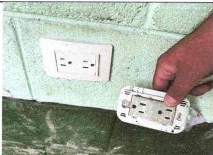
Foto: 3 SUSTITUCION DE TOMACORRIENTES DOBLES
