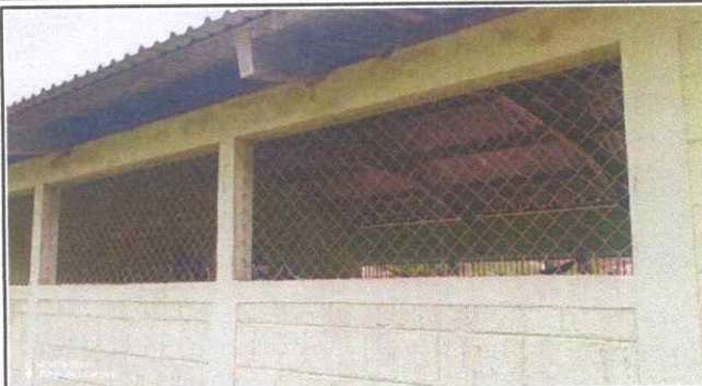
Foto 2: SUSTITUCIÓN DE BALCOES DE METAL
