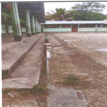
Foto 5: REPARACIÓN DE PLANCHA DE CONCRETO DE PATIO
