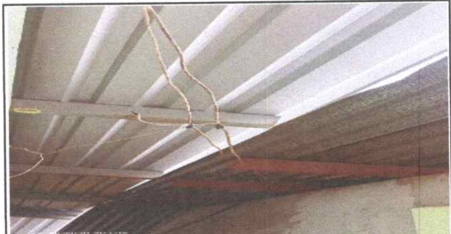
Foto 6: REPARACION DE CABLEADO ELECTRICO
