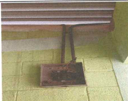
Foto 5: SUSTITUCION DE TABLEROS DE FILIPONES
