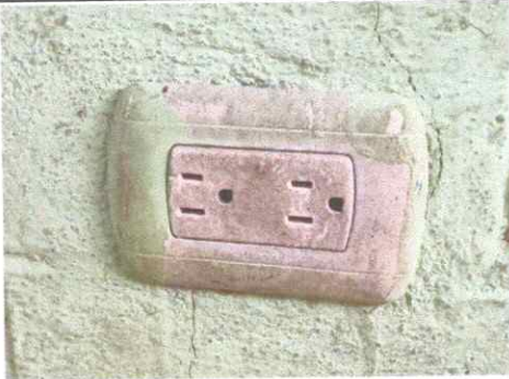
Foto 3: SUSTITUCION DE TOMACORRIENTES DOBLES
