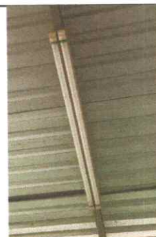
Foto 6: SUSTITUCIÓN DE LAMPARA TIPO LED
