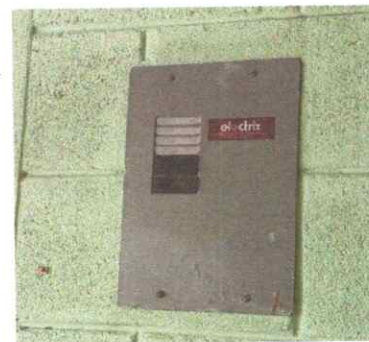
Foto 4: SUSTITUCION DE FILIPONES
