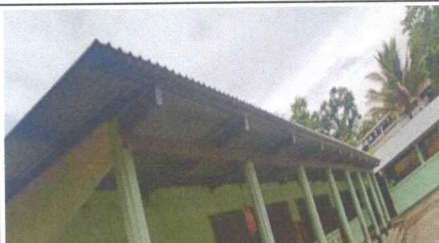
Foto 3: SUSTITUCIÓN DE CANAL DE METAL
