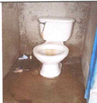
Foto 4: SUSTITUCIÓN DE INODORO
