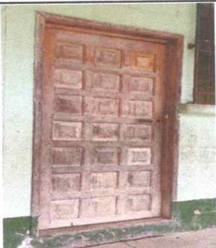
Foto 1: SUSTITUCIÓN DE PUERTAS.
