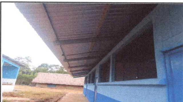
Foto 3: Sustrución de estructura de soporte de metal, por metal
