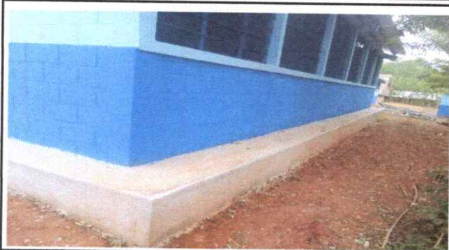
Foto 7: Reparación de banquetas de concreto
