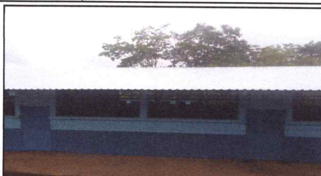
Foto 2: Sustrución de capote de támina para lámina troquelada
