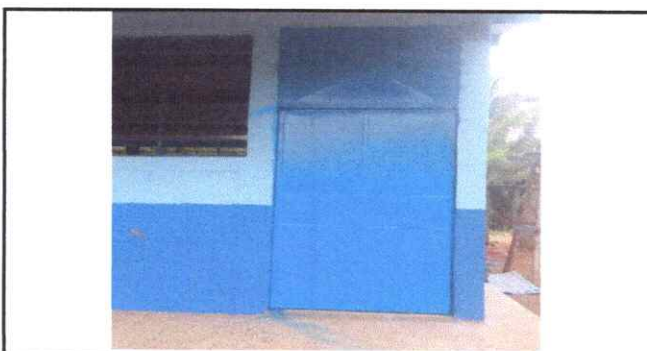
Foto 6: Sustrución de puerta
