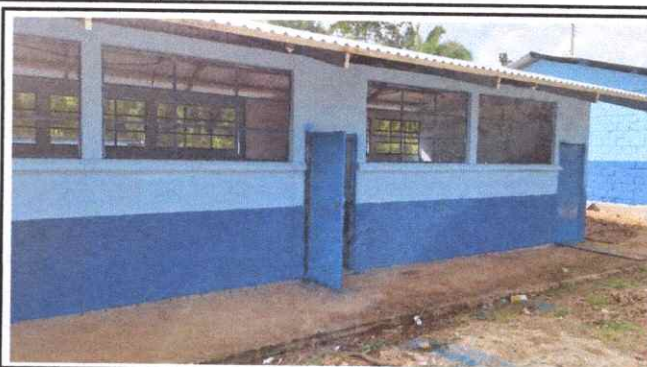
Foto 8: Pintura en muros exteriores e interiores
