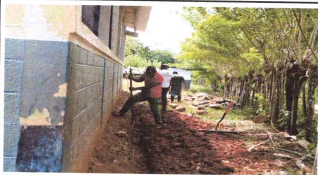
Foto 7: Reparación de banquetas de concreto
