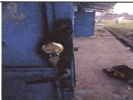
Foto 5: Sustitución de chapas
