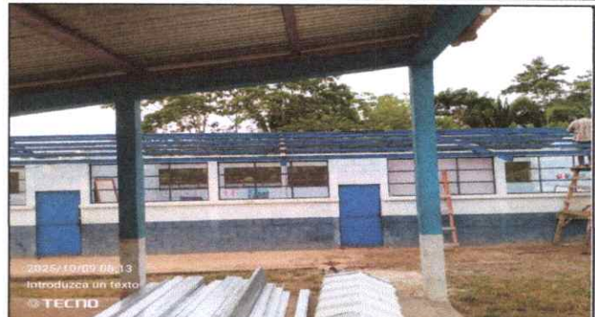
Foto 2: Sustitución de capote de támina para lámina troquelada
