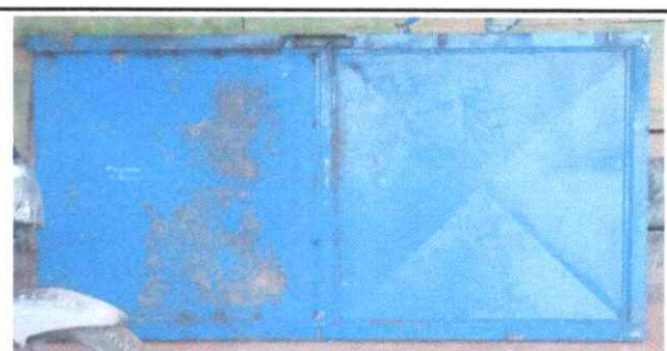
Foto 6: Sustitución de puerta
