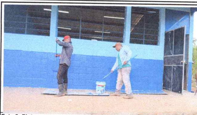
Foto 8: Pintura en muros exteriores e interiores
