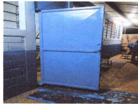
Foto 4: Mantenimiento a estructura , lijado, cambio de tubo, cepillado, sujeciones, aplicación de pintura)
