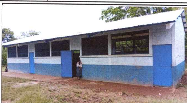
Foto 8: Pintura en muros exteriores e interiores
