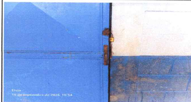
Foto 4: Mantenimiento a estructura , lijado, cambio de tubo, cepillado, sujeciones, aplicación de pintura)
