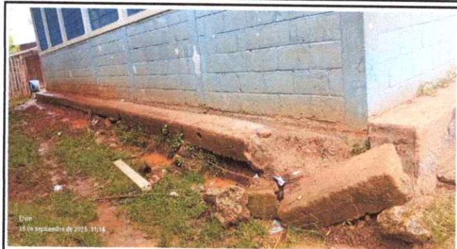
Foto 7: Reparación de banquetas de concreto
