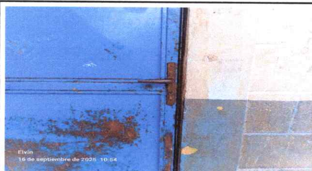
Foto 5: Sustrucción de chapas
