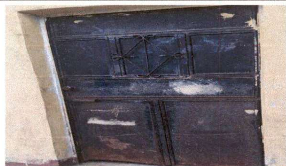
Foto 5: Sustitución de puerta.
