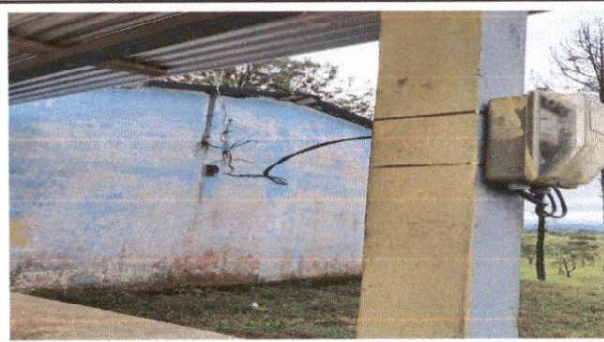
Foto 2: Reparación de cableado electrico.
