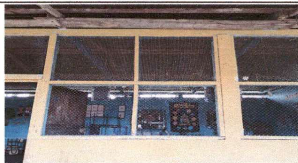
Foto 6: Sustitución de estructura de metal de ventana.
