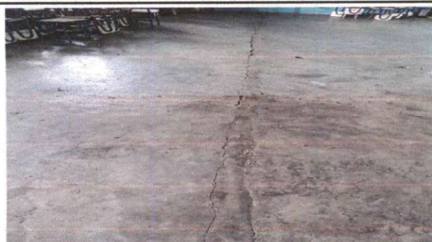
Foto1: Sustrución de piso de cemento líquido.
