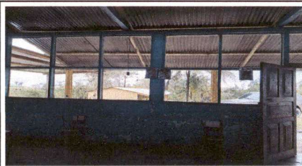
Foto 4: Pintura en muros exteriores e interiores.
