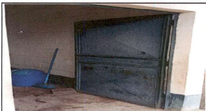
Foto 3: MANTENIMIENTO A PUERTAS DE METAL
