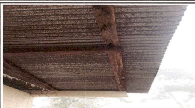
Foto 2: SUSTITUCION DE ESTRUCTURA SOPORTE DE MADERA POR METAL
