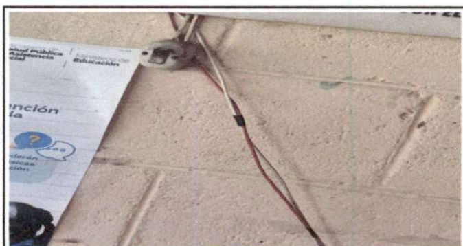
Foto 5: SUSTITUCION DE DUCTO ELECTRICO MAS ACCESORIO
