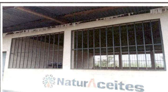
Foto 4: MANTENIMIENTO A BALCONES
