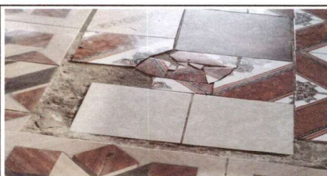
Foto 6: SUSTITUCION DE PISO CERAMICO
