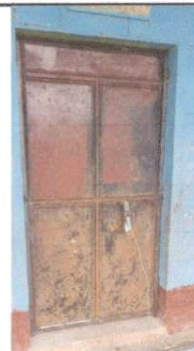
Foto 4: Sustitución de puertas de metal
