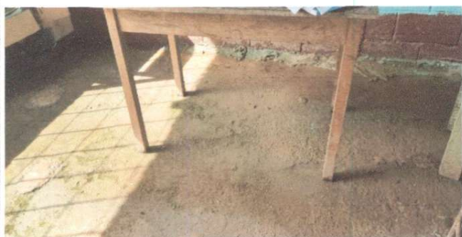
Foto 3: Sustitución de piso liquido
