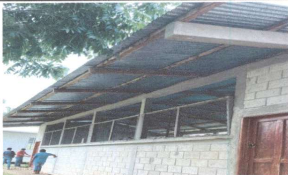
Foto1: Sustitución de lamina por lamina troquelada calibre 26.
