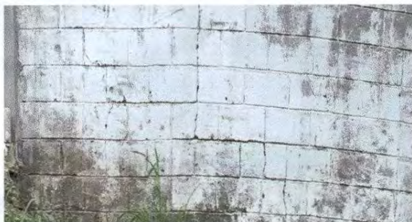
Foto 3: Reparación de muro perimetral de block
