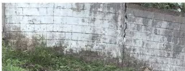
Foto 3: Reparación de muro perimetral de block
