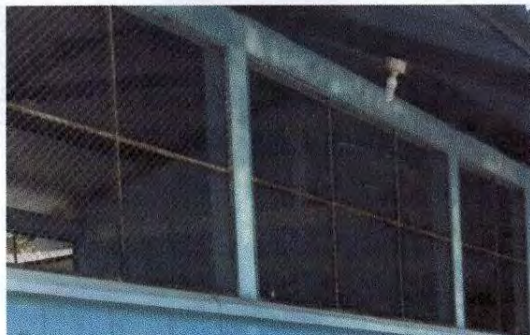
Foto 7: Fabricación e instalación de ventana-balcon de metal
