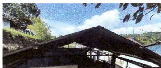
Foto 2: Sustrucción de estructura de soporte de madera, por metal
