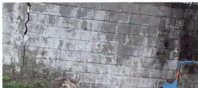
Foto 4: Reparación de muro perimetral de block
