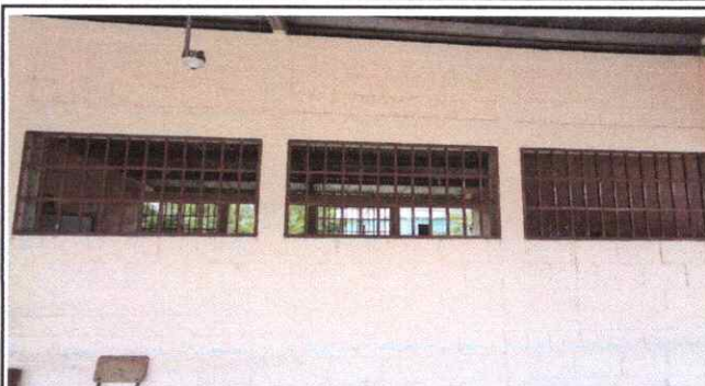
Foto 2: Sustitución de balcones de madera y malla metálica por valcones de metal
