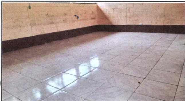
Foto 1: Mejoramiento de piso liquido por cerámico
