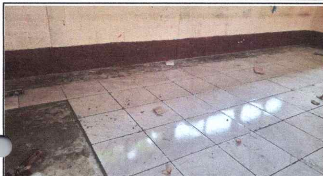
Foto 1: Mejoramiento de piso líquido por cerámico
