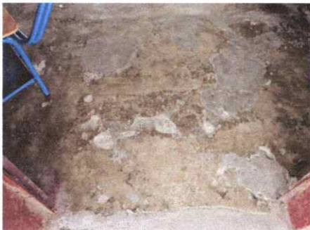
Foto 1: Mejoramiento de piso liquido por cerámico
