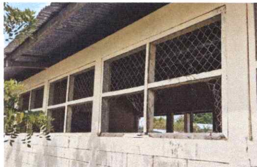
Foto 2: Sustitución de balcones de madera y malla metálica por balcones de metal
