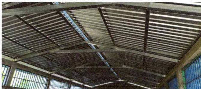
Foto 1: Sustitucion de techo
