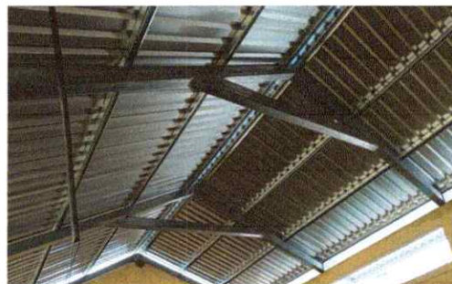
Foto 2 Sustitucion de techo
